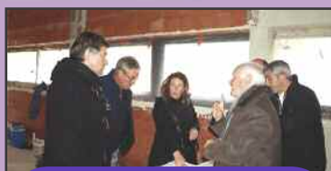
Alain Sutra, Alexandre Bermand et les dirigeants du rugby discutent des plans avec l'architecte lors d'une réunion de chantier
